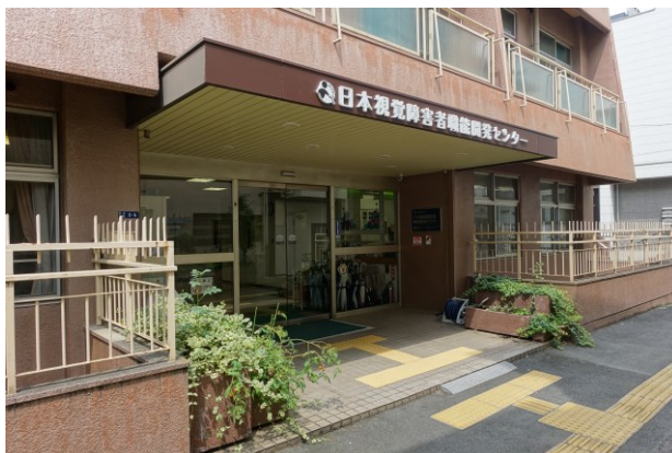
センターの外観
