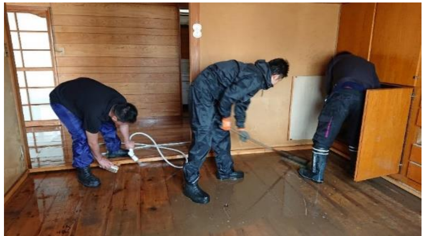
【高圧洗浄機で洗浄】
