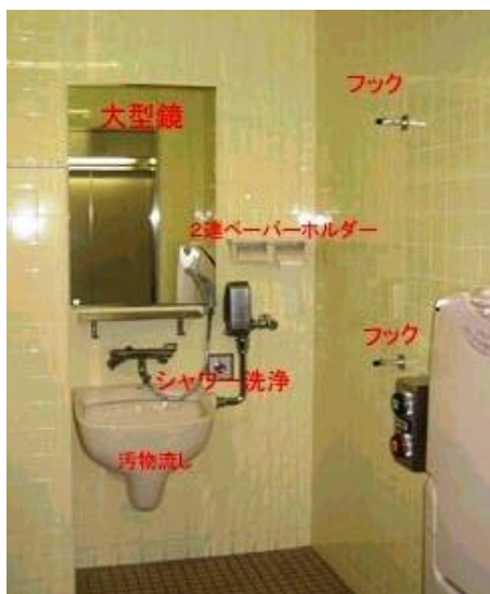
汚物流しを設けたトイレ（横浜市地下鉄）
