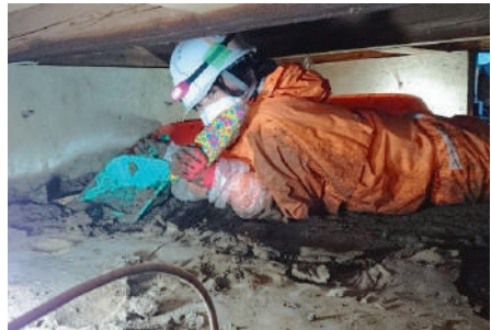
床下の泥だしの様子
