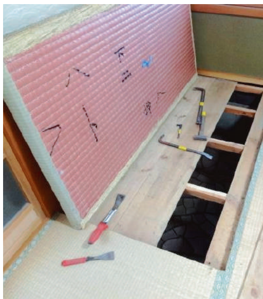
和室の床板をはがす（写真①）
